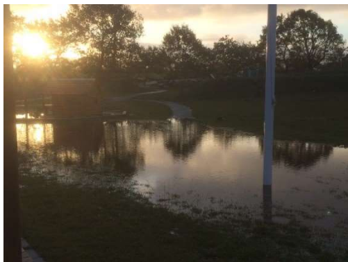
Legepladsen før dræningen blev forbedret.
